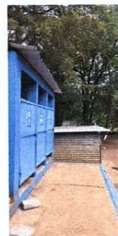
Foto 4: MEJORAMIENTO DE TECHO DE LAMINA + ESTRUCTURA METÁLICA
