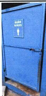
Foto 5: SUSTITUCIÓN DE PUERTAS METÁLICAS
