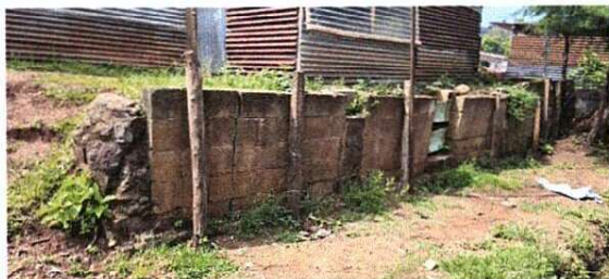
Foto 1: MEJORAMIENTO DE MURO DE CONTENCIÓN DE BLOCK
