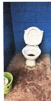
Foto 2: SUSTITUCIÓN DE INODORO
