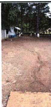
Foto 3: FUNDICIÓN DE PISO DE CONCRETO
