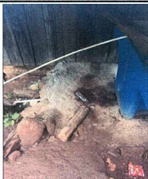
Foto 3: Base tipoTorta de concreto para pila exterior.
