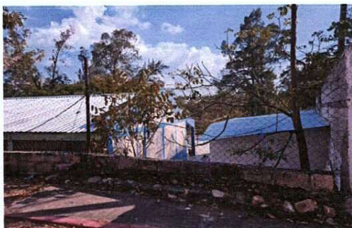
Foto 5: ESPACIO DE BODEGA
