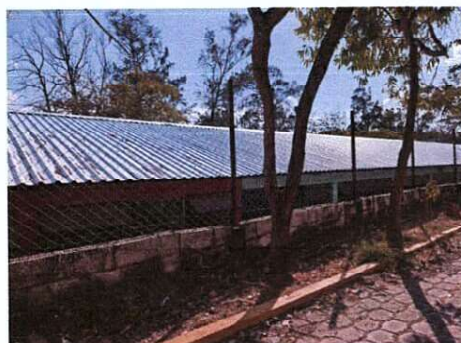
Foto 2: MURO EXTERIOR ORIENTE
