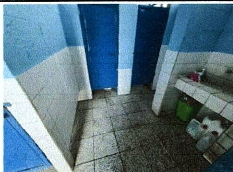
Foto 2: Sustitución de azulejo en mal estado en servicio sanitario de hombres y mujeres.
