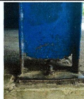
Foto 6: Fundición de bases en columnas de metal que soportan estructura de techo del Centro Educativo.
