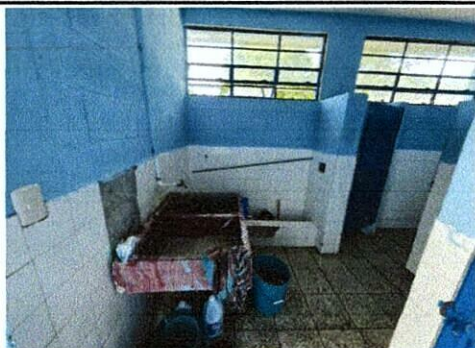
Foto1: Sustitución de azulejo en mal estado en servicio sanitario de hombres y mujeres.
