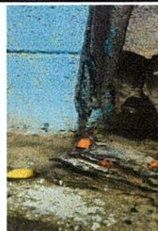
Foto 6: Fundición de bases en columnas de metal que soportan estructura de techo del Centro Educativo.
