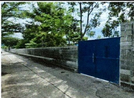
Foto 5: Mejoramiento de muro perimetral.
