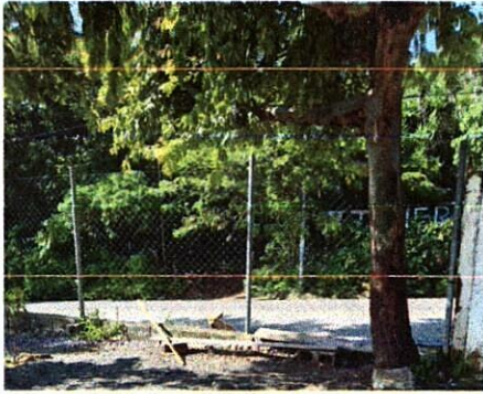
Foto 1: SUSTITUCIÓN DE MURO PERIMETRAL
