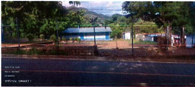
Foto 3: SUSTITUCIÓN DE MURO PERIMETRAL
