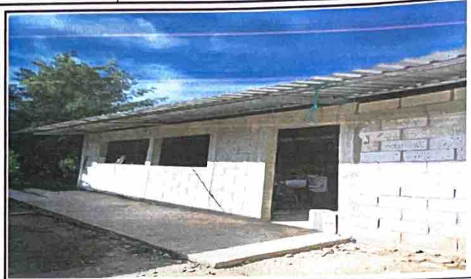
Foto 2: MEJORAMIENTO EN INSTALAR PUERTA Y BALCONES EN EL AULA
