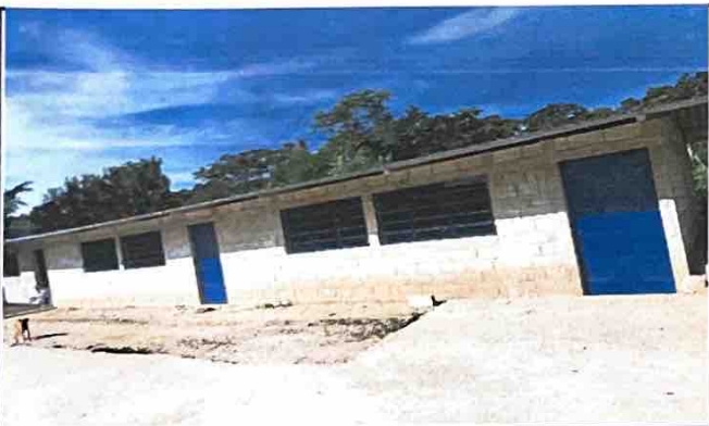
Foto 3: MEJORAMIENTO DE PATIO
