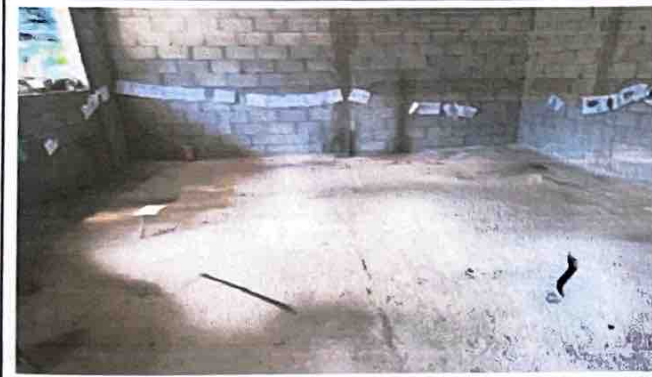
Foto1: MEJORAMIENTO DE PISO EN EL AULA
