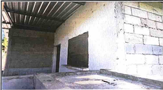
Foto 6: MEJORAMIENTO DE VENTANA EN COCINA
