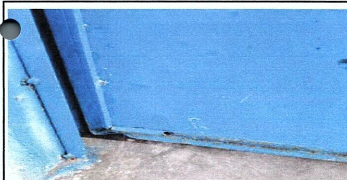
Foto 5: SUSTITUCIÓN DE PUERTA METÁLICAS
