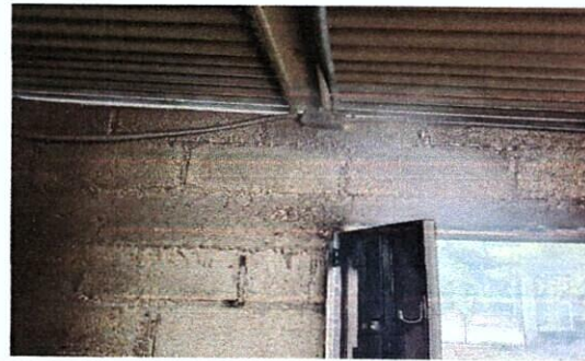
Foto 8: SUSTITUCION DE CONEXIÓN ELECTRICA
