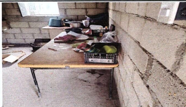
Foto 1: MEJORAMIENTO DE MESA DE CONCRETO
