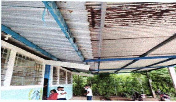
Foto 7: MEJORAMIENTO DE CANAL BAJADA DE AGUA
