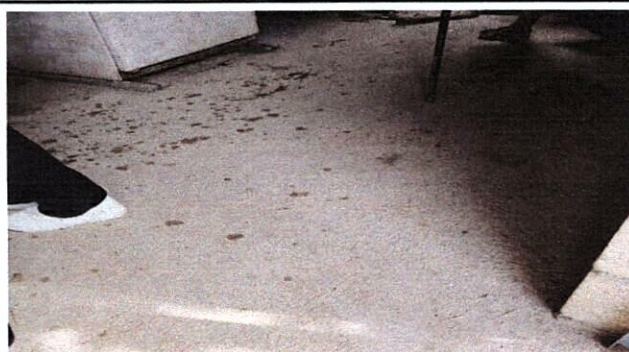
Foto 2: MEJORAMIENTO DE PISO CERÁMICO
