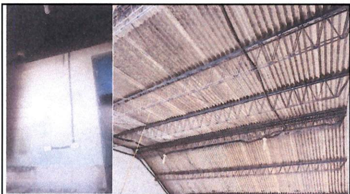
Foto 3: INSTALACIÓN DE UNIDADES LUZ (INCLUYE CAJA, ABRAZADERA DUCTO Y CABLE ELÉCTRICO) INSTALACIÓN DE INTERRUPTOR (INCLUYE CAJA, ABRAZADERA, DUCTO Y CABLE ELÉCTRICO)
