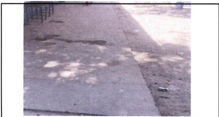
Foto 5: MEJORAMIENTO DE NIVELACIÓN, COMPACTACIÓN Y RELLENO
