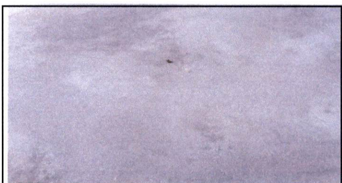
Foto 6: MEJORAMIENTO DE LOSA DE PATIO
