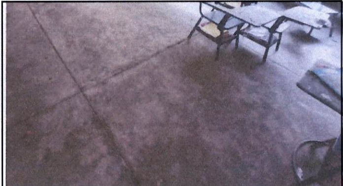
Foto 2: MEJORAMIENTO DE PISO EN MODULO (INCLUYE CONTRAPISO)
