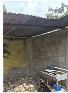
Foto 2: Sustrucción de lámina de zinc ondulada por lámina troquelada
