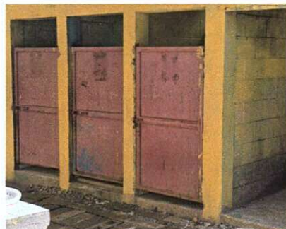
Foto 4: Sustrucción de puertas de metal de sanitarios
