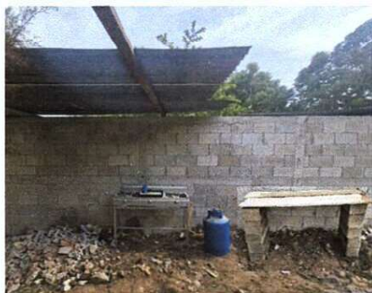
Foto 1: Sustrucción de mesa de madera por mesa de concreto
