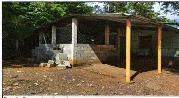
Foto 5: Reparación de cocina
