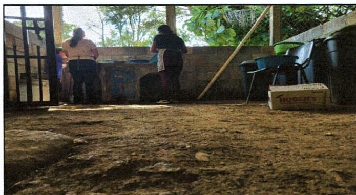
Foto 3: Reparación de piso
