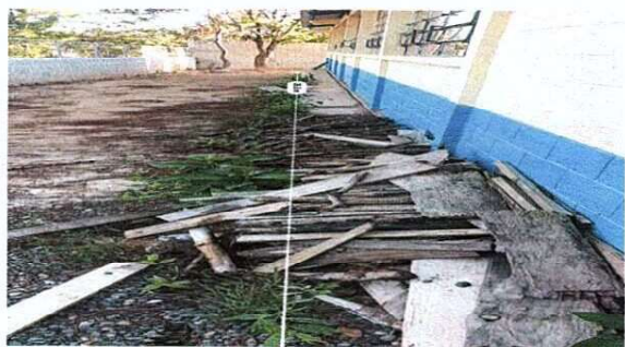
Foto 3: mejoramiento de piso en patio
