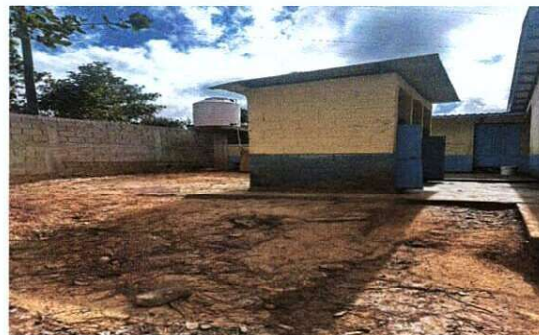
Foto 2: mejoramiento de fosa séptica
