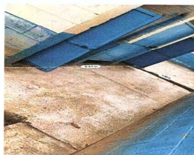
Foto 6: mejoramiento de servicios sanitarios
