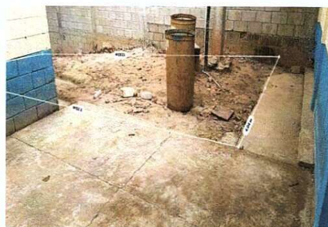
Foto 4: mejoramiento de piso en patio
