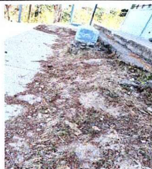
Foto 2: Mejoramiento de piso de concreto en patio a desbaste de terreno y lanzamiento de sabieta.
