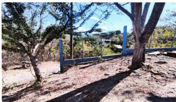
Foto 1: Sustrucción de malla galvanizada en muro perimetral en los tramos que se encuentra en mal estado.
