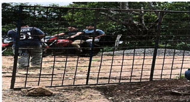
Foto 9: mejoramiento de portón de malla
