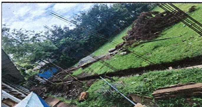
Foto 6: Mejoramiento de muro perimetral
