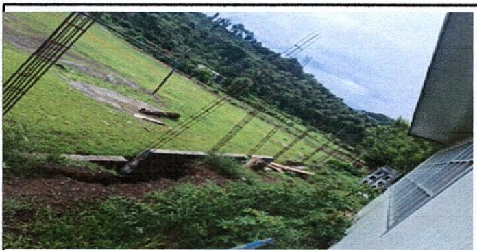
Foto 5: Mejoramiento de muro perimetral
