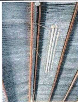
Foto1: MEJORAMIENTO DE TECHO DE LAMINA ACANALADA CON ESTRUCTURA DE METAL, INSTALACIÓN DE CAPOTE Y CANAL METALICO
