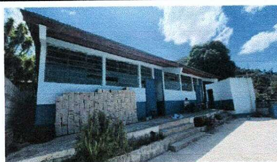
Foto 12: PINTURA EN MUROS INTERIORES Y EXTERIORES
