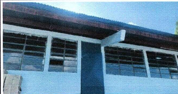
Foto 2: MEJORAMIENTO DE TECHO DE LAMINA ACANALADA CON ESTRUCTURA DE METAL, INSTALACIÓN DE CAPOTE Y CANAL METALICO
