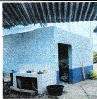
Foto 4: MEJORAMIENTO DEL AREA DE COCINA
