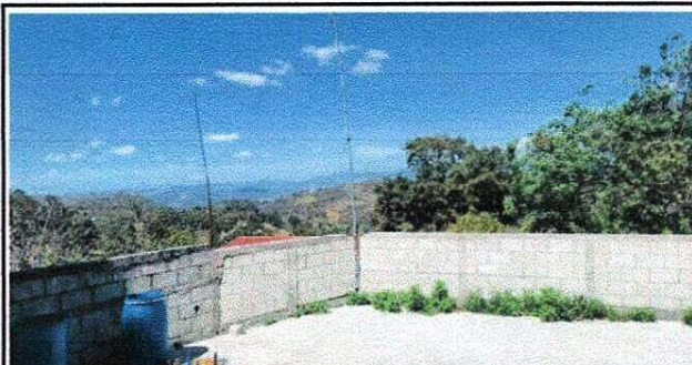
Foto 6: MEJORAMIENTO DE MURO PERIMETRAL
