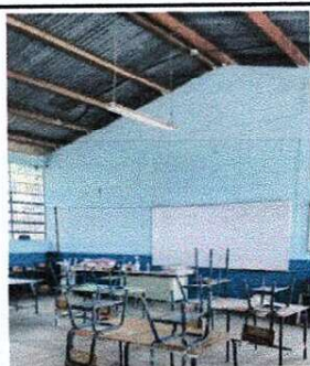
Foto 11: PINTURA EN MUROS INTERIORES Y EXTERIORES
