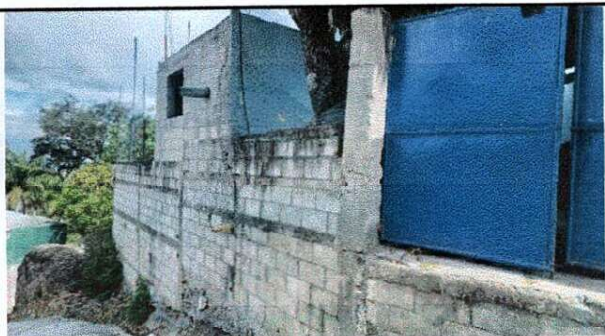
Foto 9: REPELLO Y CERNIDO EN PAREDES
