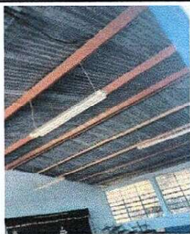
Foto1: MEJORAMIENTO DE TECHO DE LAMINA ACANALADA CON ESTRUCTURA DE METAL, INSTALACIÓN DE CAPOTE Y CANAL METALICO
