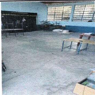
Foto 7: SUSTITUCIÓN DE PISO DE CONCRETO POR PISO DE GRANITO
