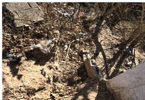
Foto 2: LEVANTADO DE MURO DE BLOCK
