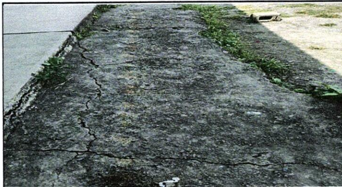
Foto 2: Sustrución de concreto en mal estado y preparación de suelo
