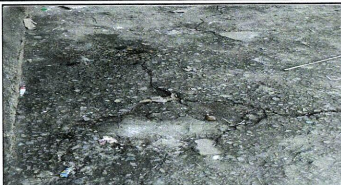
Foto 1: Sustrución de concreto en mal estado y preparación de suelo
