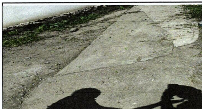
Foto 3: Sustrución de concreto en mal estado y preparación de suelo
