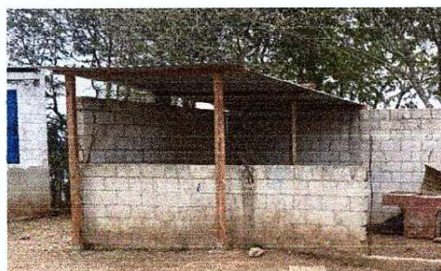
Foto 4: vista exterior del aula a remozar muros , techo, piso y banquetta.
