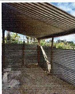
Foto 1: vista exterior del espacio que se dispone como cocina escolar actualmente
