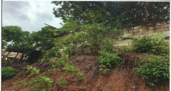
REFORMACIÓN MURO DE CONTENCIÓN
