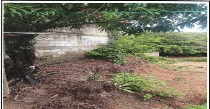
REFORMACIÓN DE MURO
