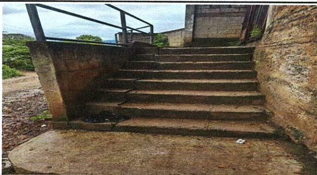
REPARACIÓN GRADAS DE ENTRADA
