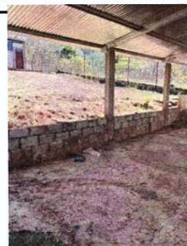
Foto 4: 4.0 REPARACIÓN DE MURO EN GALERÍA: Se construirá un muro a continuación del existente para dar cerramiento en una escuadra, se hará con block sisado de 15 x 20 x 40 cms, incluye columnas y soleras.
