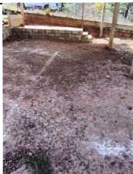
Foto 5: 5.0 PISO: Se fundirá con concreto el patio de galera con un espesor de 10 cms también se colocará piso cerámico en escenario y parte de aula.
