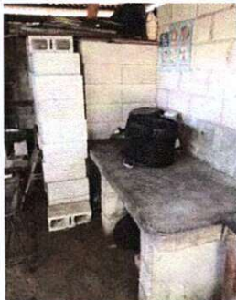
Foto 1: 1.0 REPARACIÓN DE COCINA: Cocina se hará un remozamiento de mesa de concreto, se hará dos poyetones con plancha de cocina, se colocará azulejo en estufa y planchas de concreto, remozamiento de piso concreto faltante.
