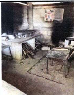
Foto 3: 3.0 PINTURA MUROS INTERIOR: Se pintará los muros del área de cocina.
