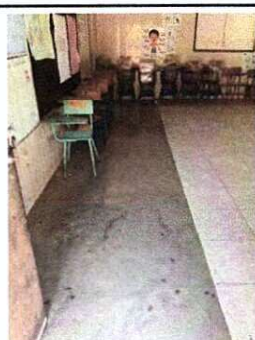
Foto 5: 5.0 PISO: Se fundirá con concreto el patio de galera con un espesor de 10 cms también se colocará piso cerámico en escenario y parte de aula.
