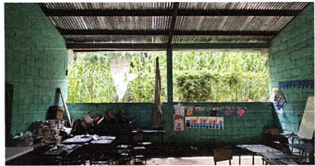
Foto 2: Mejoraiento de ventanas y balcones en aula
