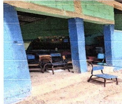
Foto 4: Mejoramiento de puertas y banqueta
