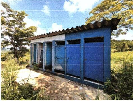
Foto1: Mejoramiento de techo y puerta en baños
