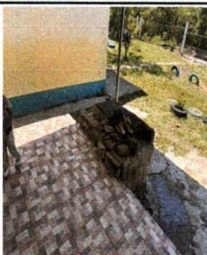
SUSTITUCION DE POLLETON
