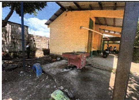
MEJORAMIENTO DE PINTURA
