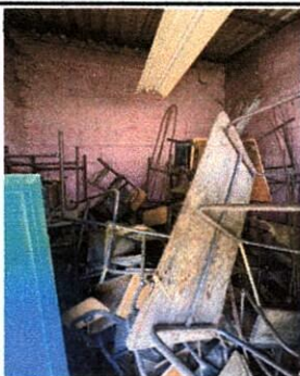
MEJORAMIENTO DE MAMPOSTERIA
