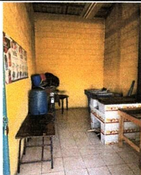
MEJORAMIENTO DE MAMPOSTERIA
