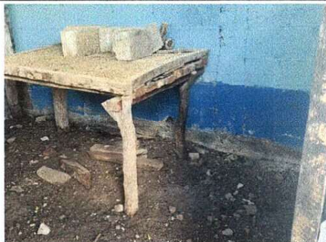
Foto 1: Reparación de Estufa rural. de Fundición de base para estufa rural
