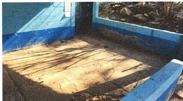
Foto 8: Reparación de piso de plancha fracturada por fundición de torta
