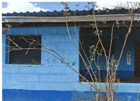
Foto 10: Reparación de Canales de lámina
