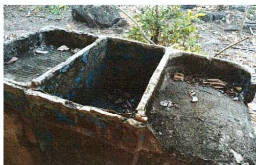
Foto 5: Sustitución de pila por pila de un lavadero
