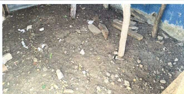
Foto 2: Sustitución piso de adobe por fundición de torta de cocina
