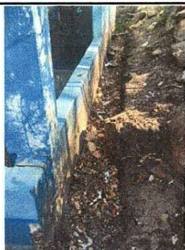
Foto 11: Sustrucción de cuneta de piedra por base fundida
