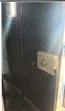
Foto 7: Sustrucción puerta para cocina
