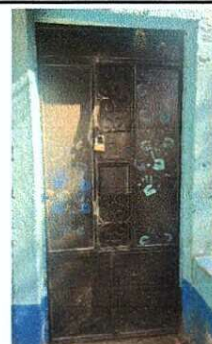
Foto 6: Sustitución puerta principal
