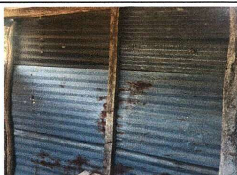
Foto 4: Sustitución de lámina acanalada por lámina troquelada
