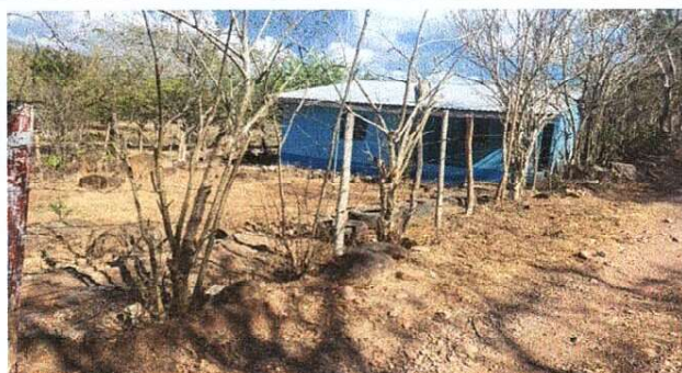
Foto 9: Mejoramiento de muro perimetral
