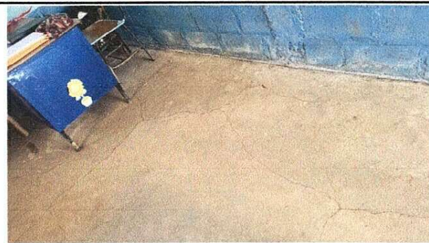
Foto 12: Mejoramiento de piso de concreto
