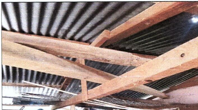
Foto 4: SUSTITUCIÓN DE VIGAS Y COSTANERAS DE MADERA POR METÁLICAS SUSTITUCIÓN DE LÁMINA CANALADA POR LÁMINA ALUZIN CALIBRE 26
