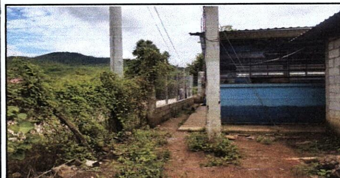
Foto 5: MEJORAMIENTO DE MURO PERIMETRAL
