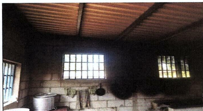
Foto 3: MEJORAMIENTO MURO DE BLOCK
