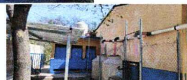
Foto 4: Área de aulas: Remozamiento de pintura lavable en exteriores.
