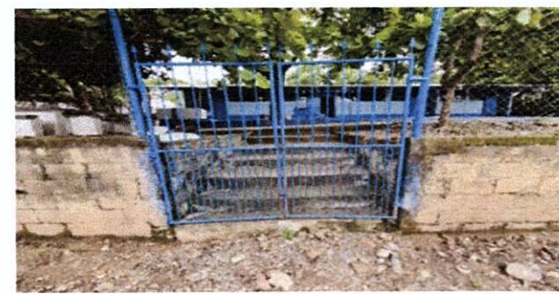
Foto 6: Remozamiento en portón.
