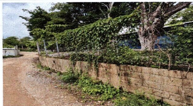
Foto 3: Remozamiento de muro perimetral.
