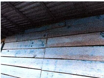
Foto 4: SUSTITUCIÓN DE TECHO DE LAMINA
