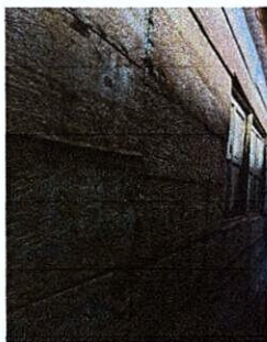
Foto1: MEJORAMIENTO DE MUROS EN AULA
