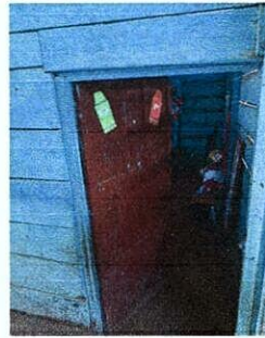
Foto 2: SUSTITUCIÓN DE PUERTA METÁLICA
