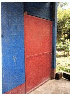
Mantenimiento de las puertas de las aulas
