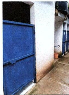
Mantenimiento de las puertas de los sanitarios
