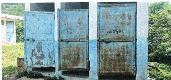
Foto 1: Mantenimiento a estructura de puertas
