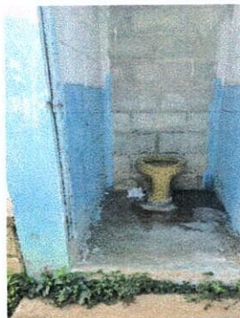
Foto 2: Sustitución e instalación de servicios sanitarios.
