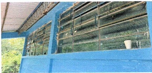
Foto 5: Sustitución de ventanas y manetimiento de balcón
