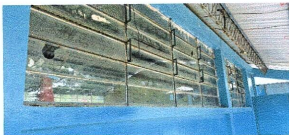
Foto 4: Sustitución de ventanas y manetimiento de balcón
