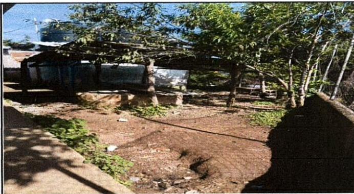
Foto 3: impermeabilización de losa, patio 2
