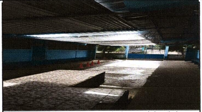
Foto 2: estructura de techo, estructura y lamina troquelada patio 1
