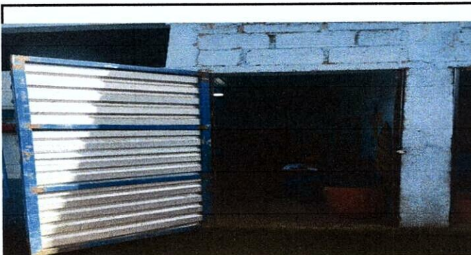
Foto 9: sustitución y fabricacion de puerta lado izquierdo modulo 2
