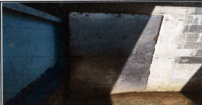
Foto 11: sustitución y fabricacion de puerta 2 cocina
