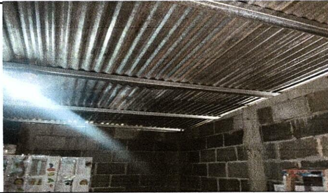
Foto1: sustitucion de techo, estructura y lamina troquelada
