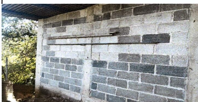
Foto 15: reparacion de repello y cernido de cocina afuera
