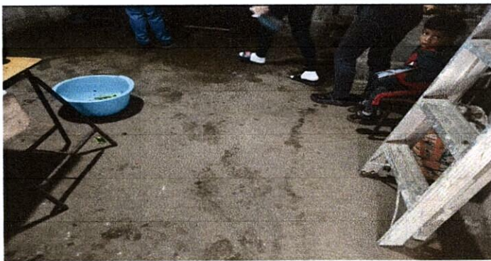
Foto 5: sustitucion de piso ceramico
