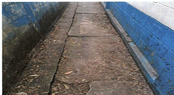
MEJORAMIENTO DE ACERA DE LA PARTE DE ATRÁS DE LA ESCUELA
