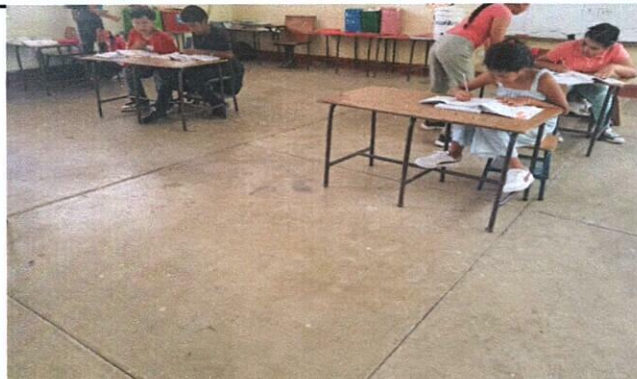
MEJORAMIENTO Y CAMBIO DE PISO DE TORTA DE CEMENTO POR PISO CERÁMICO ANTIDESLIZANTE EN LAS AULAS.
