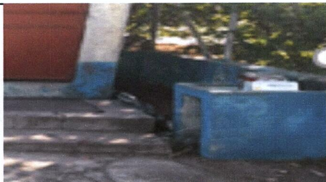
MEJORAMIENTO DE PILA PEQUEÑA.
