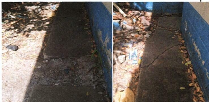
MEJORAMIENTO DE CUNETA Y MEJORAMIENTO DE ACERAS LATERALES
