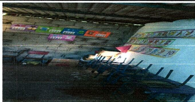
Foto 5: MEJORAMIENTO DE PAREDES
