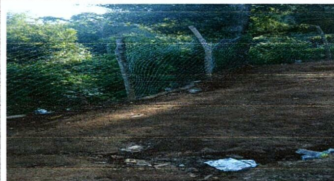
Foto 4: MEJORAMIENTO DE MURO PERIMETRAL
