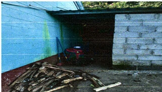
Foto1: MEJORAMIENTO ESTRUCTURA DE TECHO Y COLOCACION DE PUERTA DE METAL
