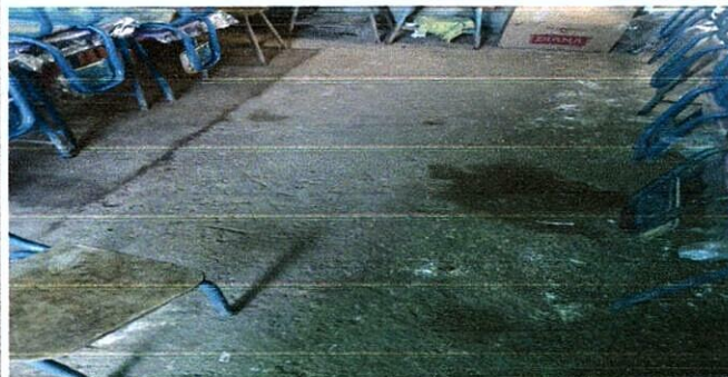
Foto 2: MEJORAMIENTO DE TORTA DE CEMENTO POR PISO CERAMICO
