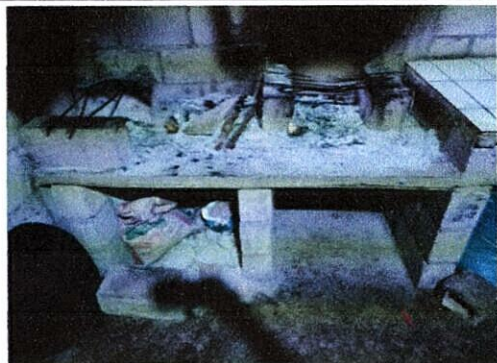
Foto 1: SUSTITUCIÓN DE ESTUFA RURAL QUE INCLUYE CHIMENEA Y PLANCHA DE METAL
