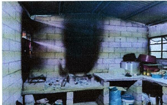
Foto 2: MEJORAMIENTO DE MUROS, APLICACIÓN REPELLO Y CERNIDO EN AREA DE COCINA
