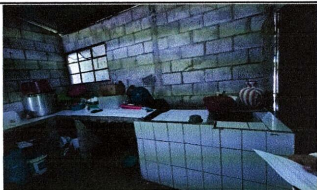
Foto 3: MEJORAMIENTO DE MUROS, APLICACIÓN REPELLO Y CERNIDO EN AREA DE COCINA
