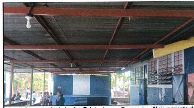
Foto 6: Desmontaje de lámina Existente area Escenario y Mejoramiento de Pintura en muros exteriores
