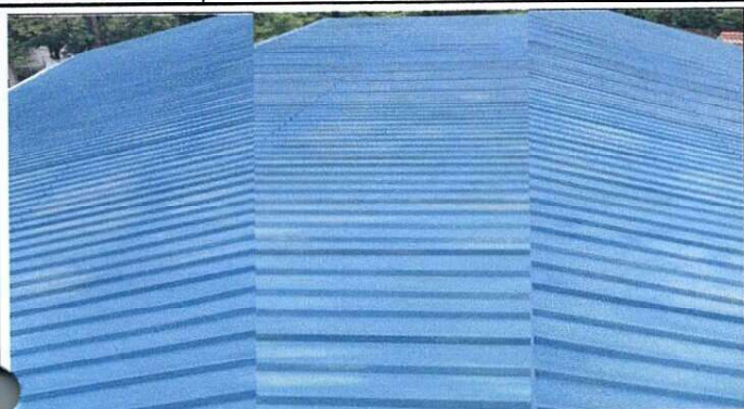
Foto 1: Desmontaje de lámina Existente area de Dirección y Sustitución de lámina por lámina aluzinc calibre 26 area de Dirección
