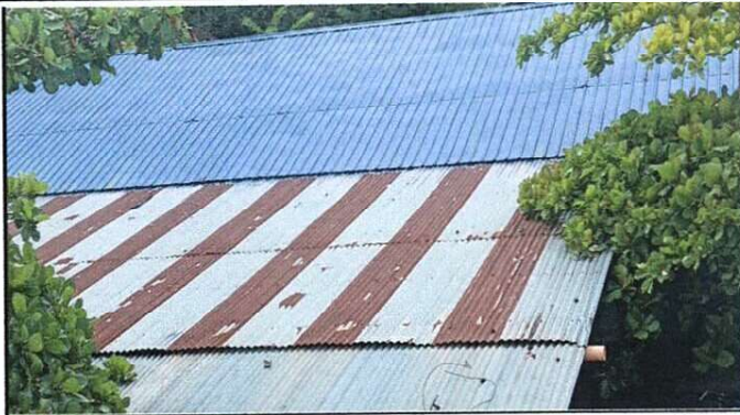
Foto 2: Desmontaje de lámina Existente area de Módulos y Sustitución de lámina por lámina aluzinc calibre 26 Desmontaje de lámina Existente de Módulos de Aulas 2do., 3ro. y 4to.
