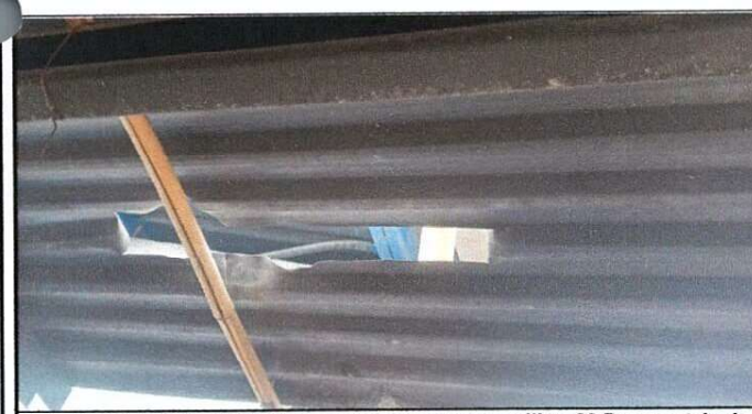
Foto 5: Sustitución de lámina por lámina aluzinc calibre 26 Desmontaje de lámina Existente area del Pasillo y Sustitución de estructura de soporte de madera, por metal en area de Pasillo
