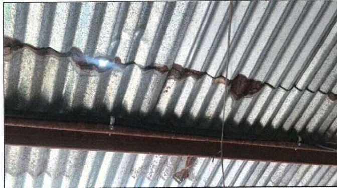
Foto 4: Desmontaje de lámina Existente area de Dirección e Instalación lámina por lámina Corredor
