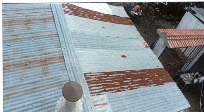
Foto 3: Desmontaje de lámina Existente area Cocina e Instalación lámina por lámina aluzinc calibre 26 Cocina
