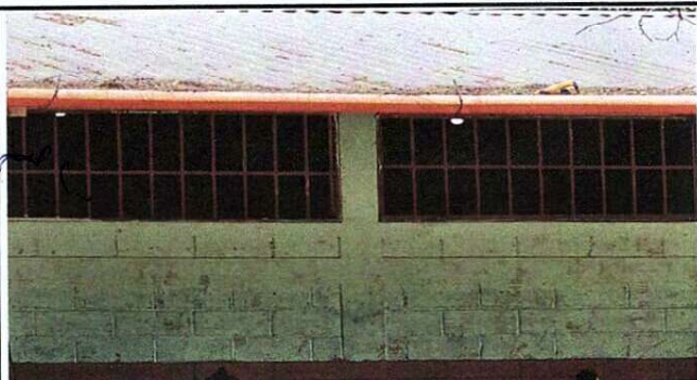
Foto 3: MEJORAMIENTO DE VENTANA
