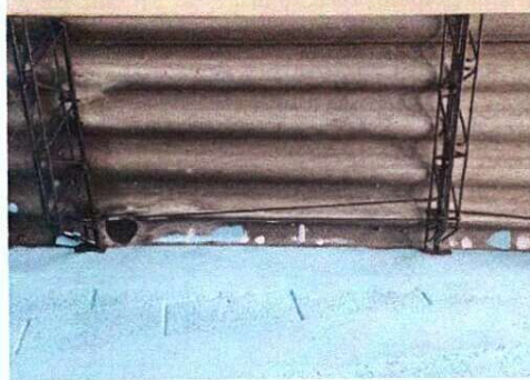
Foto 2: CUBIERTA DE LAMINA
