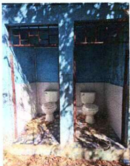
Foto1: MEJORMIENTO DE SANITARIOS
