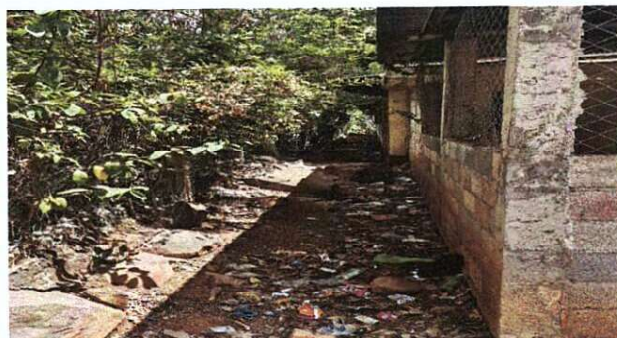
Foto 4: MEJORAMIENTO DE CUNETAS DE CONCRETO
