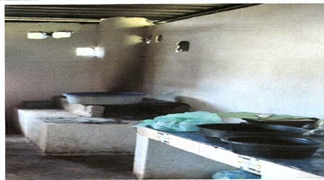
Foto: Reparacion de azulejo de mueble para cocina
