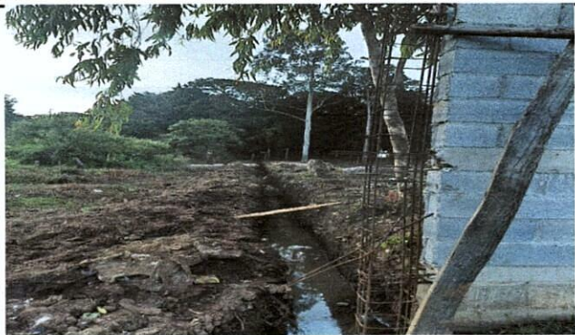
Foto: mejoramiento de muro perimetral
