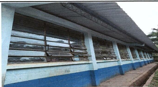
Foto: mejoramiento de valcones de metal en ventanas
