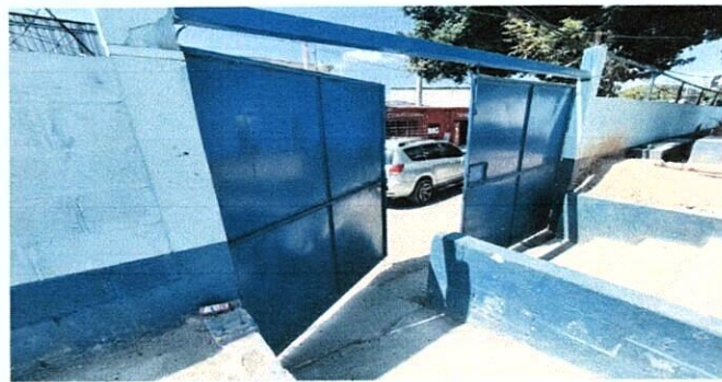
Foto 4: Sustitucion de portón metalico
