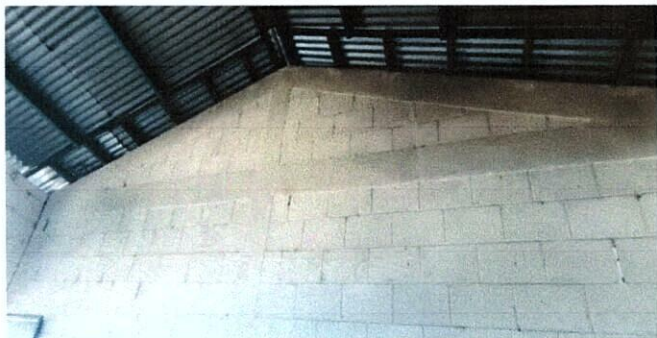
Foto1: Sustrucción de rellenos de pared
