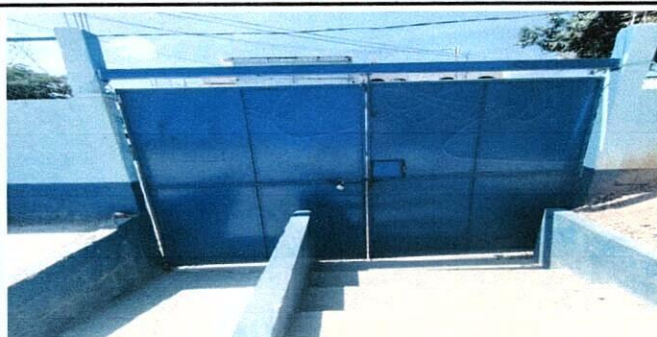
Foto 5: Remodelación de portón
