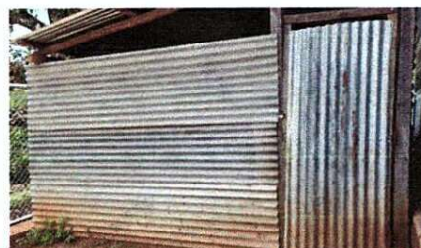
Foto 4: SUSTITUCIÓN A MUROS DE BLOCK SISADO
