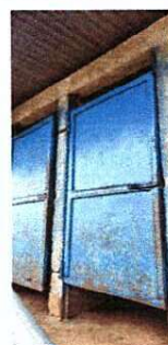
Foto 2: MEJORAMIENTO DE PUERTAS DE SERVICIOS SANITARIOS
