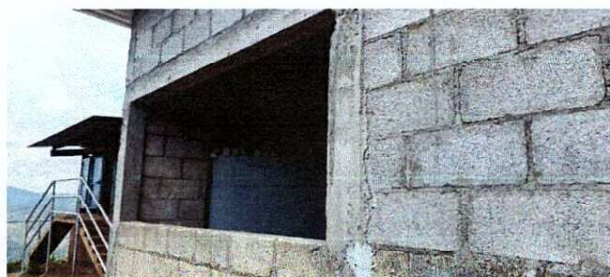
Foto 3: INSTALACIÓN DE BALCON
