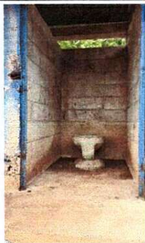
Foto 1: SUSTITUCIÓN DE INODOROS
