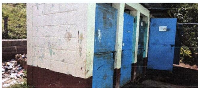
Foto 6: SUSTITUCIÓN DE PUERTAS METÁLICAS
