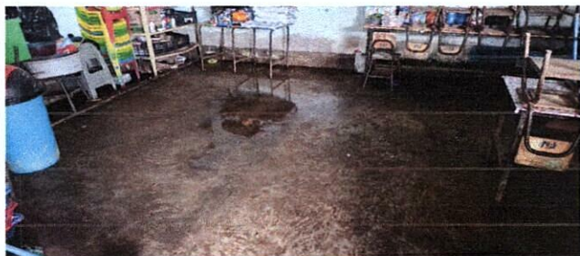
Foto1: SUSTITUCIÓN DE PISO DE CONCRETO
