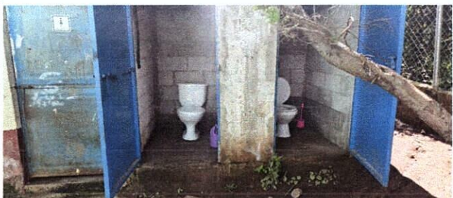
Foto 5: SUSTITUCIÓN DE SANITARIOS, MEJORAMIENTO DE PISO CERAMICO, MEJORAMIENTO DE AZULEJO EN MUROS
