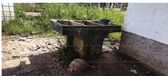
Foto 4: SUSTITUCIÓN DE PILA
