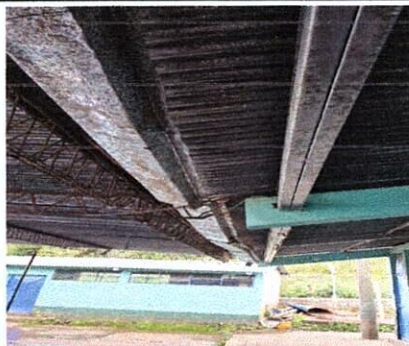
Foto 2: SUSTITUCIÓN DE CANAL METÁLICO
