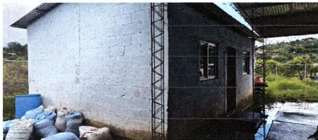
Foto 3: MEJORAMIENTO DE PINTURA EN MUROS
