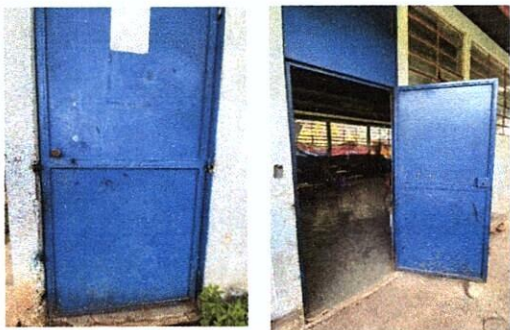
Foto1: Mantenimiento a estructura de 2 puertas de aulas.
