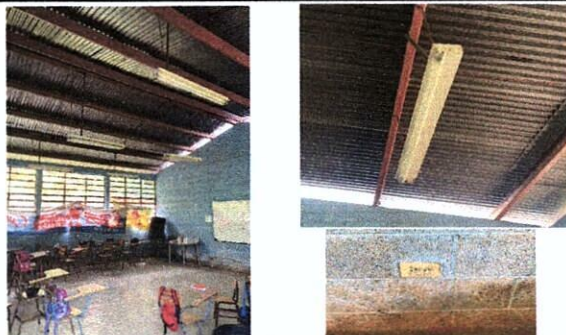
Foto 6: Reparación de sistema eléctrico aulas.
