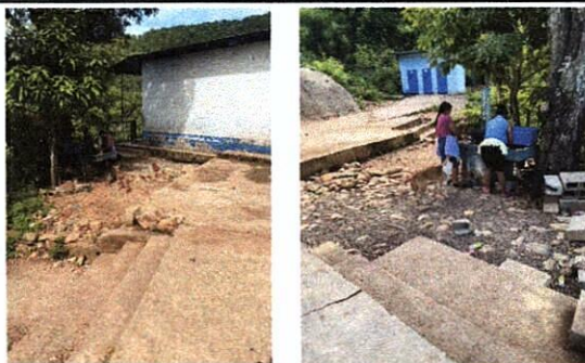
Foto 5: Reparación de planchas de concreto de patio.
