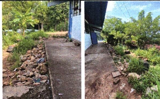
Foto 4: Reparación de planchas de concreto de patio.
