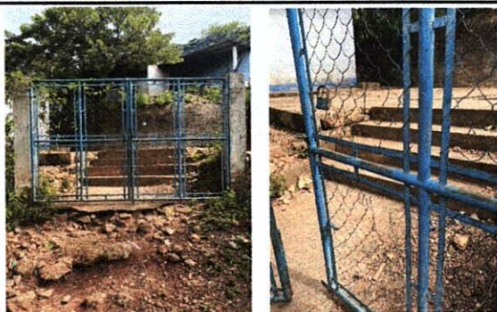
Foto 3: Mantenimiento a portón de metal.
