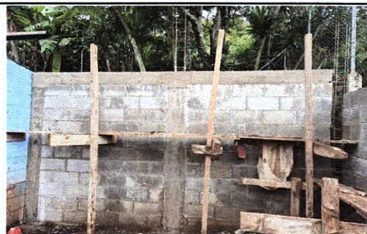
Foto 6: MEJORAMIENTO DE MURO DE BLOCK
