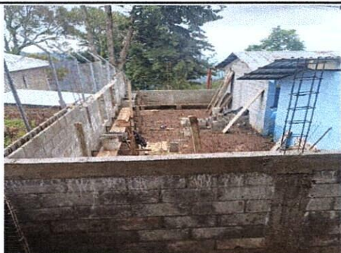
Foto 1: MEJORAMIENTO DE CUBIERTA DE LAMINA TROQUELADA Y MEJORAMIENTO DE ESTRUCTURA PORTANTE
