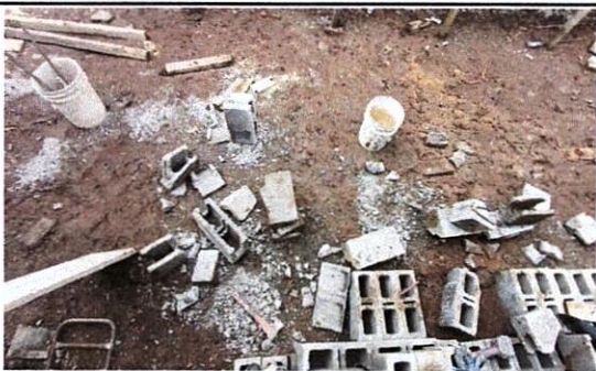
Foto 5: MEJORAMIENTO DE PISO DE CONCRETO
