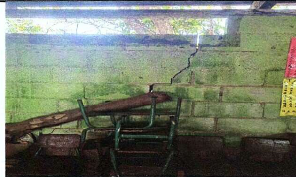
Foto 4: MEJORAMIENTO DE AULA
