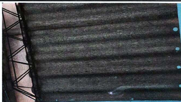
Foto 3: CUBIERTA DE LAMINA
