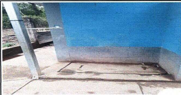
Foto 3: Limpieza de fosa séptica
