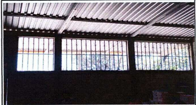
Foto 2: Instalación de ventanas de PVC (12 Ventanas).
