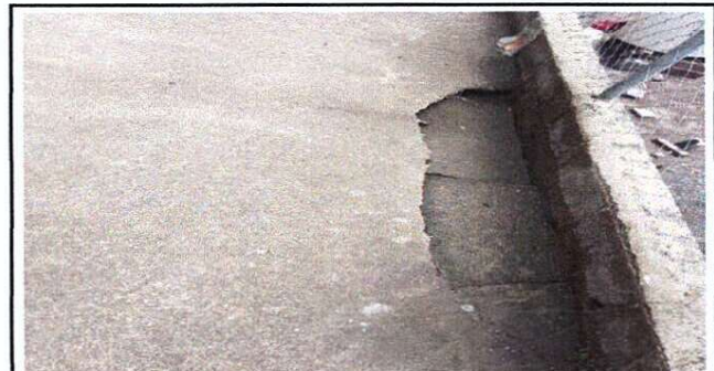
Foto 6: Reparación de planchas de concreto.
