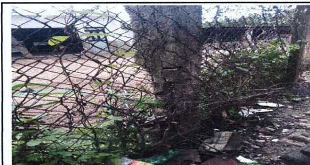
Foto 5: Reparación de muro perimetral de block, levantado de pared de muro perimetral (1 metro), sustitución de tubos galvanizados y malla galvanizada
