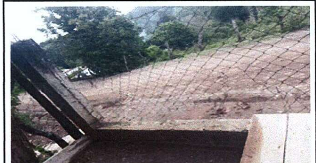
Foto 4: Reparación de muro perimetral de block, levantado de pared de muro perimetral (1 metro), sustitución de tubos galvanizados y malla galvanizada
