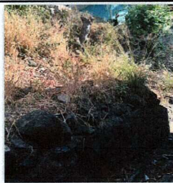
Foto 2: MURO DE CONTENCIÓN
