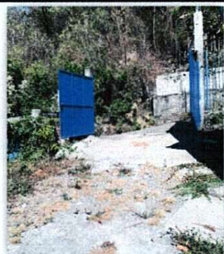
Foto 3: TORTA DE CONCRETO
