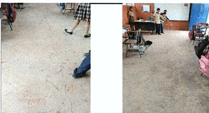
Foto 5: REPARACION DE TORTA EN AULA POR PISO
