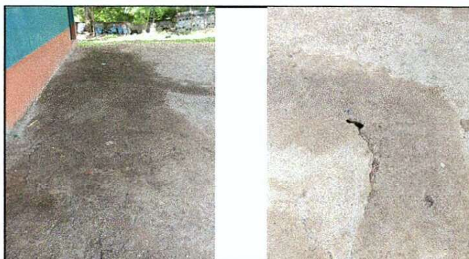
Foto 4: REPARACION DE TORTA DE CEMENTO
