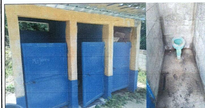
Foto 5: *Sustitución de accesorios indoro (contra llave, tubo de abasto y tanque) SUSTITUCIÓN DE AZULEJO, Mantenimiento a estructura (lijado, cepillado, aplicación de pintura) de baños
