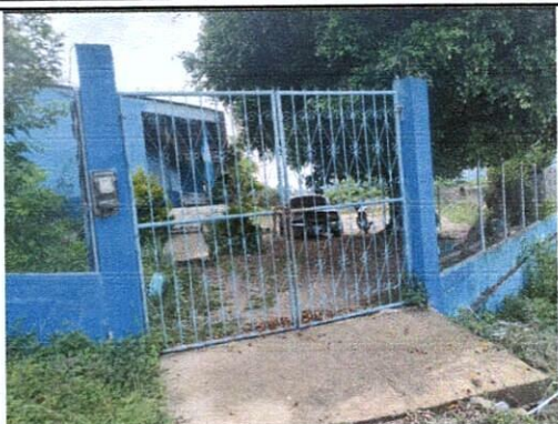
Foto7: Mantenimiento a porton de metal
