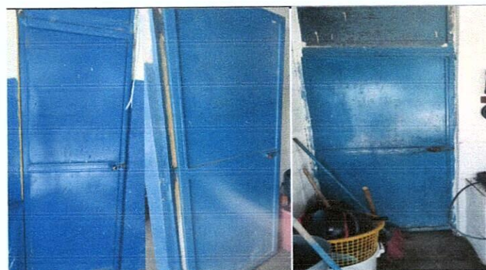
Foto 4: Mantenimiento a estructura (lijado, cepillado, sujeciones, aplicación de pintura) instalación de chapa de módulos interiores
