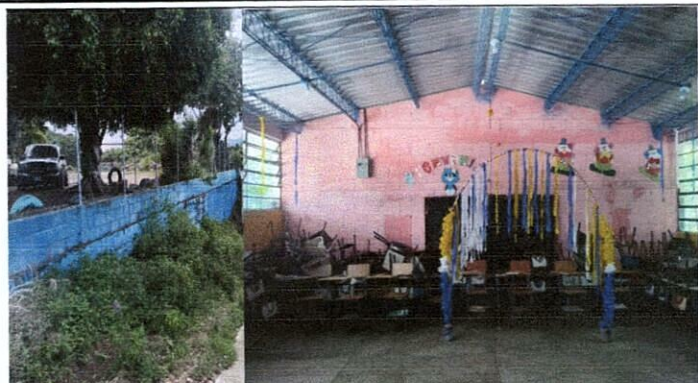
Foto 2: Pintura en muros exteriores e interiores
