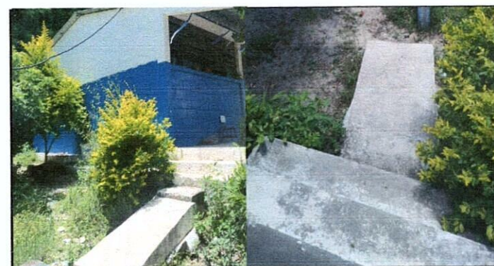
Foto 6 : Reparación de planchas de concreto de patio
