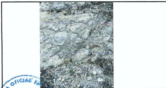
Foto 5: MEJORAMIENTO DE LOSA DE CONCRETO DE PATIO CON DELIMITACIÓN DE BLOCK
