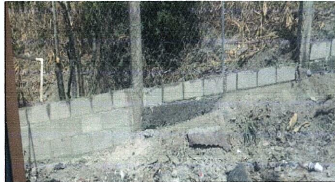
Foto 4: SUSTITUCIÓN DE MALLA SOBRE MURO PERIMETRAL (MALLA A 1.5 METROS A BASE FUNDIDA)
