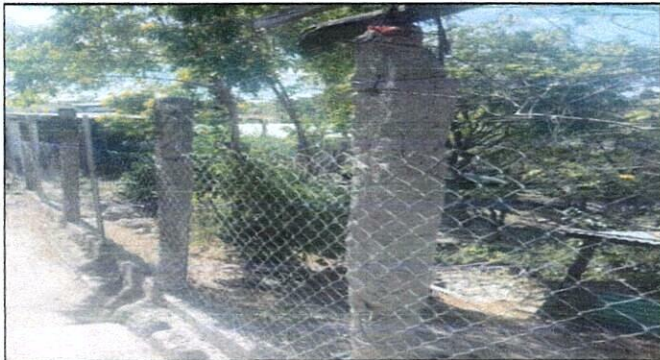
Foto 3: SUSTITUCIÓN DE MALLA SOBRE MURO PERIMETRAL (MALLA A 1.5 METROS A BASE FUNDIDA)
