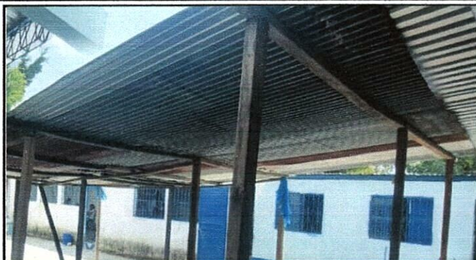
Foto 2: SUSTITUCIÓN DE LÁMINA POR LÁMINA TROQUELADA ALUZINC, MEJORAMIENTO DE BAJADA DE AGUA PLUVIAL
