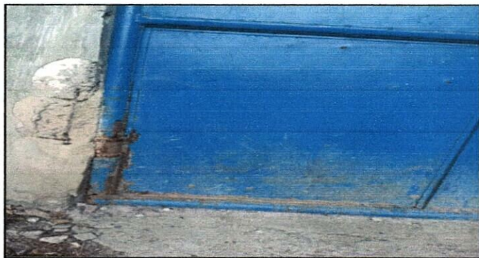
Foto 5: SUSTITUCIÓN DE PORTÓN DE METAL
