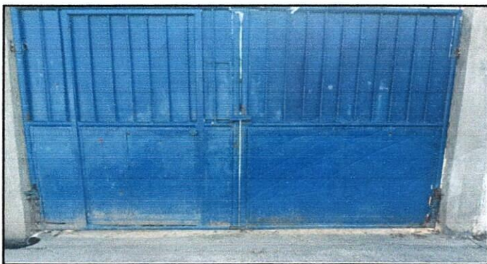
Foto 6: SUSTITUCIÓN DE PORTÓN DE METAL
