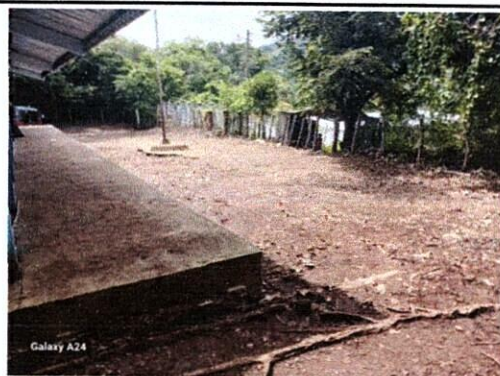
Foto 4: MEJORAMIENTO DE TORTA DE CONCRETO EN CORREDOR Y PATIO
