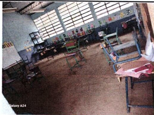
Foto 2: MEJORAMIENTO DE PISO DE TORTA DE CONCRETO POR PISO CERÁMICO ANTIDESLIZANTE EN AULAS
