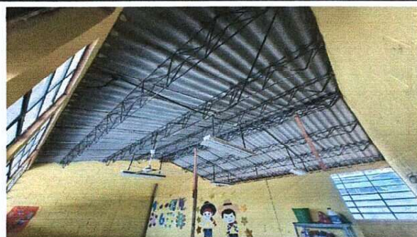
Foto 6: MEJORAMIENTO DE AULAS
