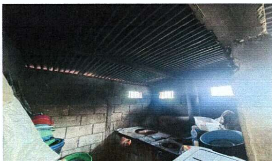
Foto 3: MEJORAMIENTO DE COCINA
