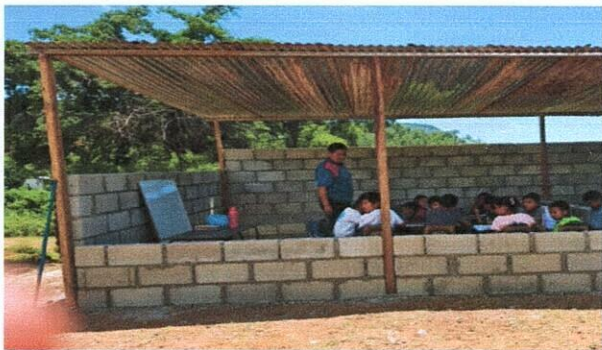
Foto1: MEJORAMIENTO MURO DE BLOCK
