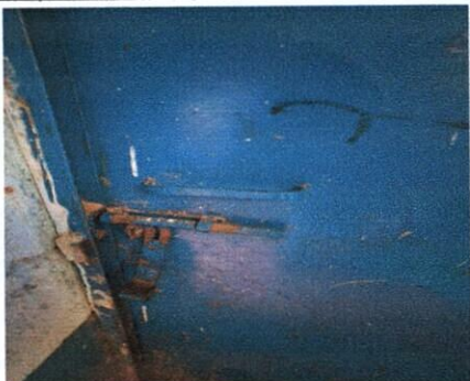
Foto1: SUSTITUCIÓN DE CHAPA METÁLICA
