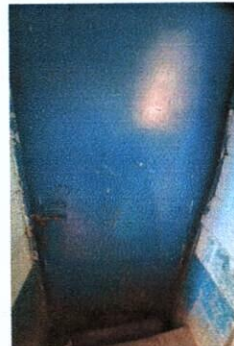
Foto 2: SUSTITUCIÓN DE PUERTA METÁLICA
