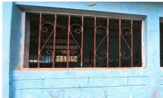
Foto 4: SUSTITUCIÓN DE BALCON METÁLICO
