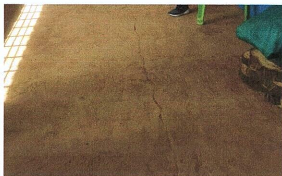
Foto 3: MEJORAMIENTO DE PISO DE CONCRETO
